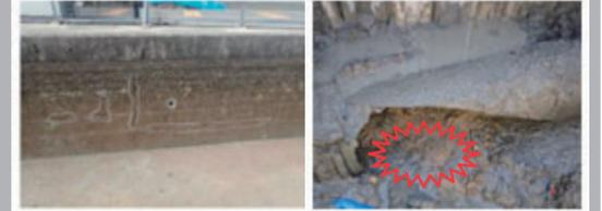
ファームボンドの摩耗 石綿セメント管の破損
