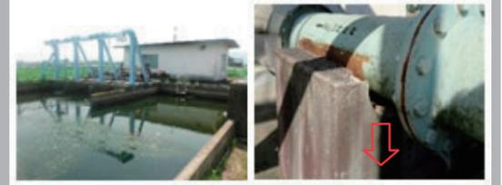
老朽化した揚水機場 機場内の地盤沈下状況
